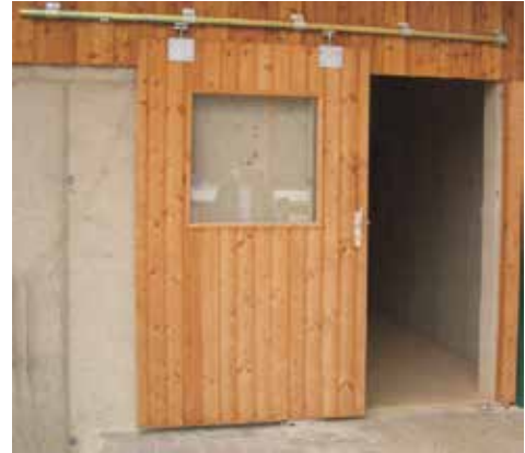
Schiebetüre Alu -Rahmensystem mit ISO Paneele und Verstärkungslaschen mit Hakenschloss
