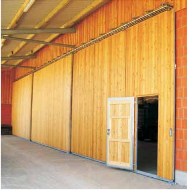
Mehrflügelige Toranlage mit verstellbaren Wandwinkeln für 3 Laufschienen, mit höhenverstellbaren Muffen und doppelpaarigen Rollapparaten, Gehüre integriert.
