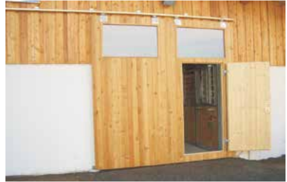
Modulare Torbauweise mit doppelpaarigen Rollapparaten und Verstärkungslaschen. Bodenführung als U - Profil im Torblatt
