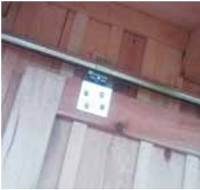
Verstärkungslasche am Torblatt mit Flansch
