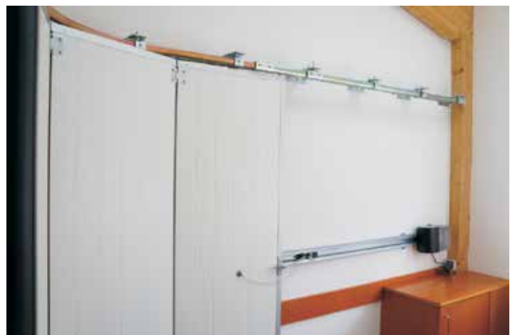
Seitensektionstor mit Antriebsmotor einlaufseitig
