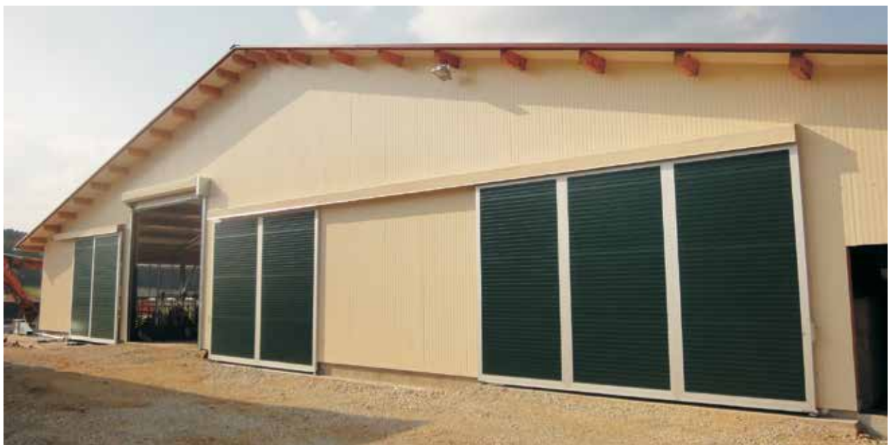
Schiebetüre Alu -Rahmensystem mit ISO Paneele und U - Bodenführung im Torblatt .
